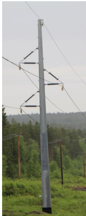
Figur 8 och 9. Exempel på stolptyper i regionnätet med vertikala linor. Till vänster (figur 8) en ledning med stolpe i fackverkskonstruktion. På denna stolpe sitter två ledningar med tre faslinor på vardera sidan om stolpen, på vänstra sidan av stolpen i detta fall 130 kV och på högra sidan 50 kV i samma stolpe. Stolptypen går ofta under benämningen "julgransstolpe" och förekommer när man behöver sambygga flera ledningar i samma stolpe. Till höger (figur 9) en stolpe med vertikala linor och topplina. Denna stolpe består av ett stålrör. Här är avstånden mellan strömförande delar stora.
