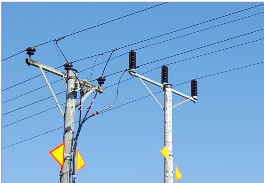
Figur 11. Ovan så kallad linepost stolpe eller enbent trästolpe med upprättstående stödisolatorer. Till höger en stolpe i regionnätet. Till vänster motsvarande konstruktion på lokalnätsledning där isolatorerna inte är lika höga. Avstånd i vertikal led från regeln upp till faslina är på regionledning vanligtvis ca 60 cm på 40–50 kV stolpe och på lokalnätsstolpe ca 20 cm.
