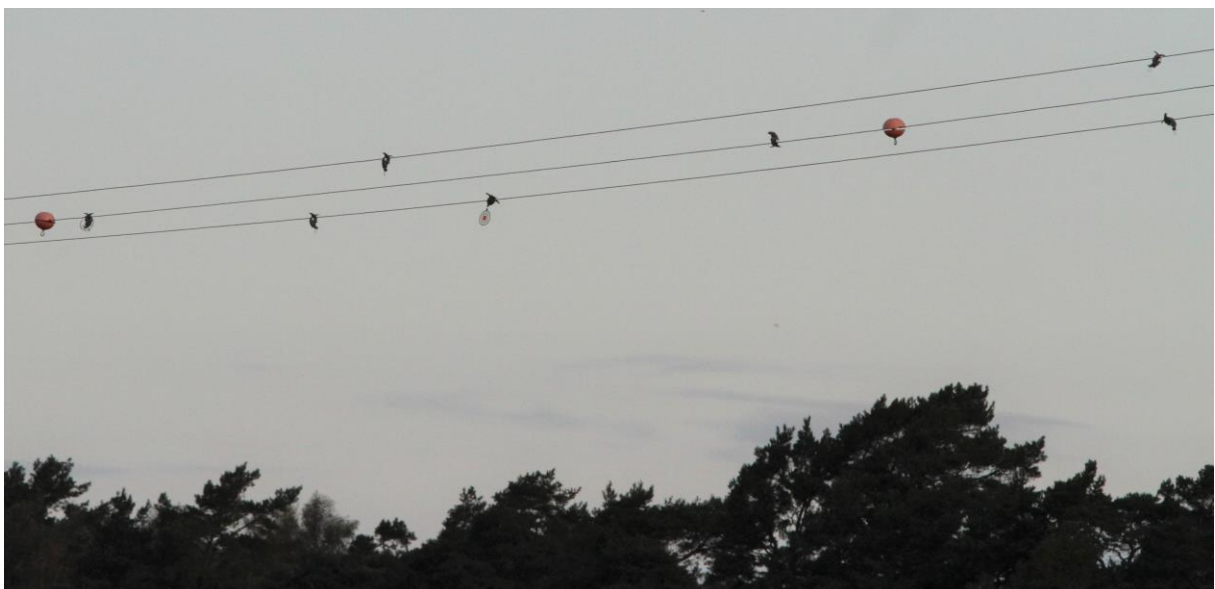
Figur 20. Två olika typer av fågelavvisare, klot och roterande markör, på kraftledning i östra Skåne. På flertalet av markörerna har den roterande delen lossnat.
