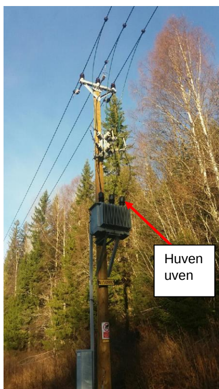
Figur 13 och 14. En nybyggd lokalnätstolpe med stolptransformator till vänster (figur 13). Transformatorns strömförande delar på ovansidan är skyddad med Huven Uven . Linorna upp till faslinorna (slackarna) är isolerade och fasavståndet är kort. De isolerade plastöverdragna linorna har en grön färgton, men de kan också vara svarta eller blåaktiga. Till höger (figur 14) en äldre stolpe med motsvarande konstruktion. Strömförande delar är inte skyddade och faslinorna består av blanktråd.
