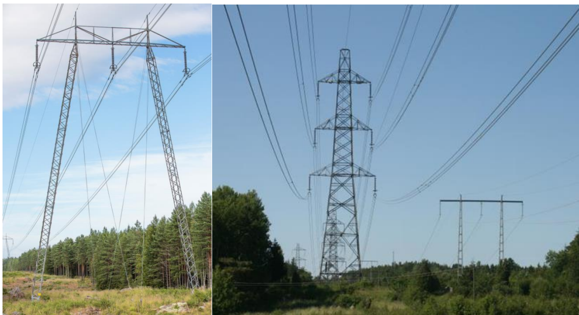
Figur 6 och 7. Exempel på vanlig portalstolpe med ben i fackverkskonstruktion till vänster (figur 6). Stolparna kan vara stagade eller ostagade. Transmissionsnätet har alltid topplina som är tunnare. På bilderna är det tydligt att flera tätt sammankopplade linor hänger i varje isolator. Till höger (figur 7) en s.k. julgrans- eller kompaktstolpe med vertikalt hängande faslinor. Här är det alltså två ledningar, dvs. sex faser som sitter i stolpen. Även här kan man också tydligt se att på varje isolator hänger flera faslinor tätt tillsammans. Till vänster i julgransstolpen hänger två linor = duplex. Till höger hänger tre faslinor på varje = triplex.
